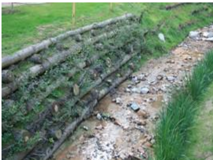
Tècniques de bioenginyeria (Ill .8)
